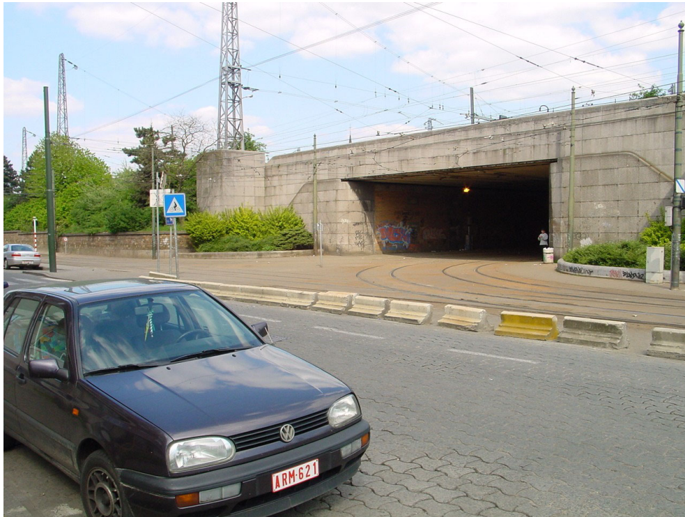
Le tunnel Thomas. De Thomastunnel.
