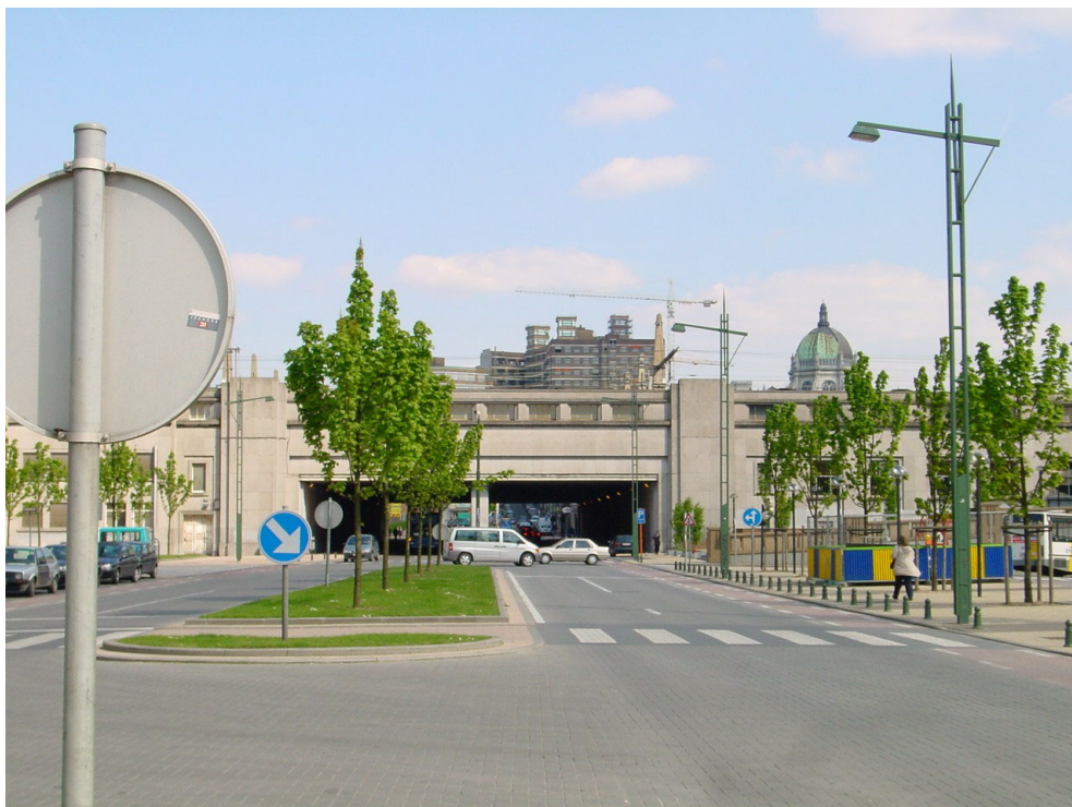
Le tunnel de la rue Quatrecht. De tunnel van de Kwatrechtstraat.
