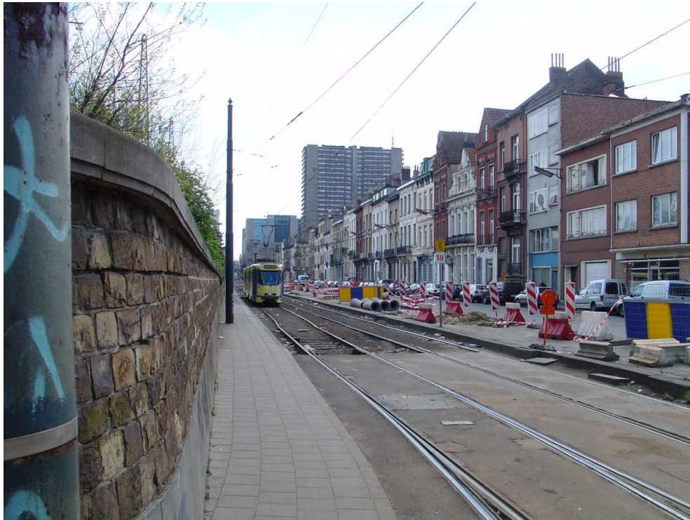
La rue du Progrès en sortant du tunnel Thomas. Vooruitgangstraat bij het uitkomen van de Thomastunnel.
