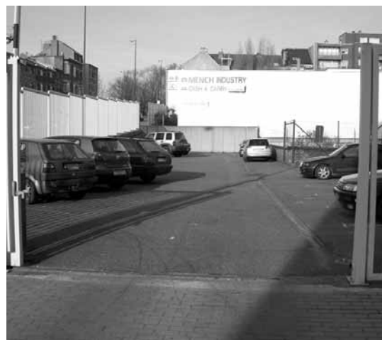
Rodenbach 14-18 : construction de 10 logements sociaux. Rodenbach 14-18 : constructie van 10 sociale woningen.
